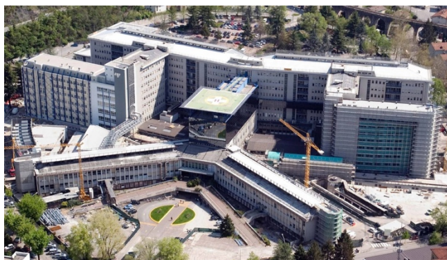
写真 4 サンタキアラ総合病院
